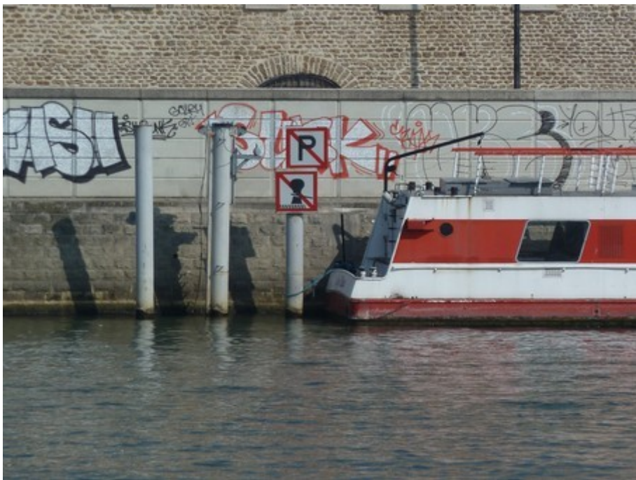
Pieux et sonde rive droite (23/03/11)
