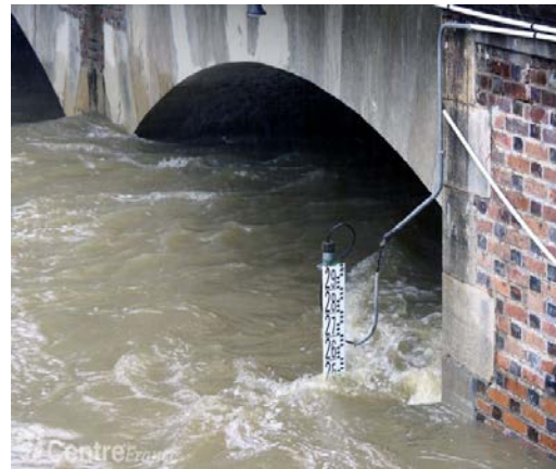
Couilly-pont-aux-dames (Grand-Morin), 09/2018- erreur de calibration du radar
