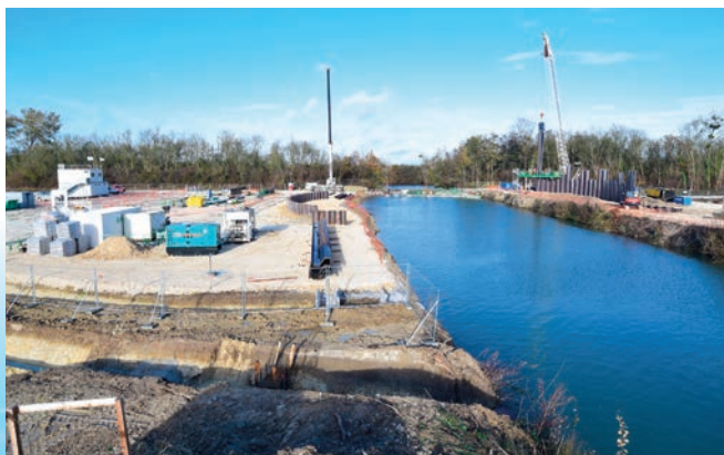
Travaux de mise en place de rideaux de palplanches
