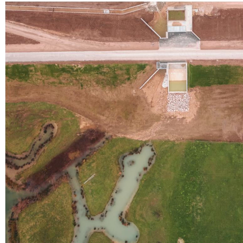
➤ Vue d'une station de relevage intermédiaire et début de la noue d'Auvergne restaurée
