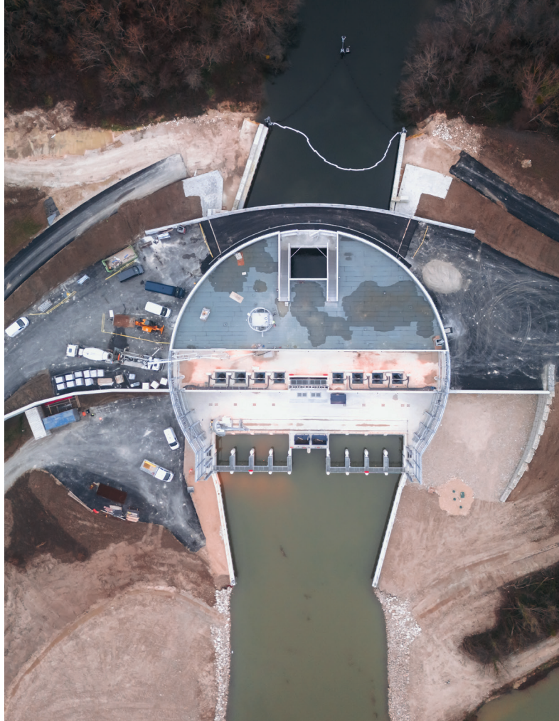
➤ Vue de la station de pompage principale
