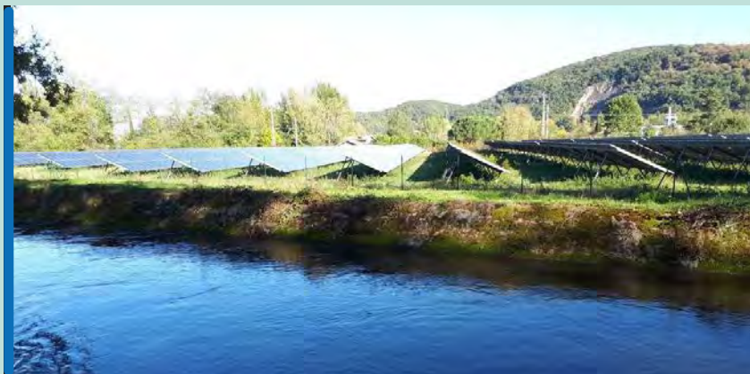
Champ terrestre de panneaux photovoltaïques
