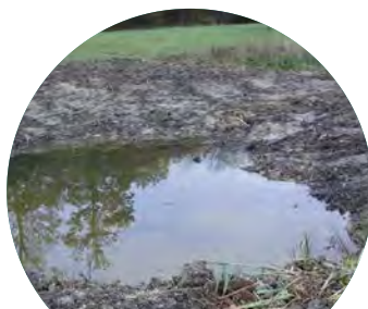
JUSTE APRÈS LES TRAVAUX
