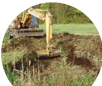
PENDANT LES TRAVAUX
